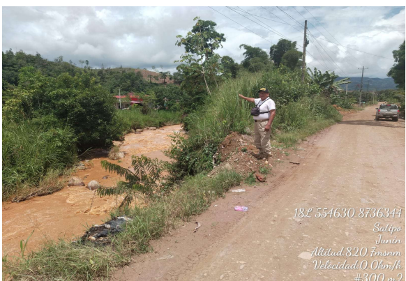
Fotografía N°3 y N°4. El Rio se encuentra colmatado con material propio. Cerca al Rio se encuentra viviendas expuestas, también se observó erosión y socavamiento de la carretera por el río
