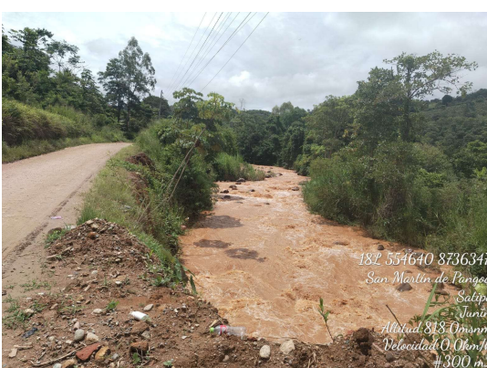
Fotografía N°3 y N°4. El Rio se encuentra colmatado con material propio. Cerca al Rio se encuentra viviendas expuestas, también se observó erosión y socavamiento de la carretera por el río
